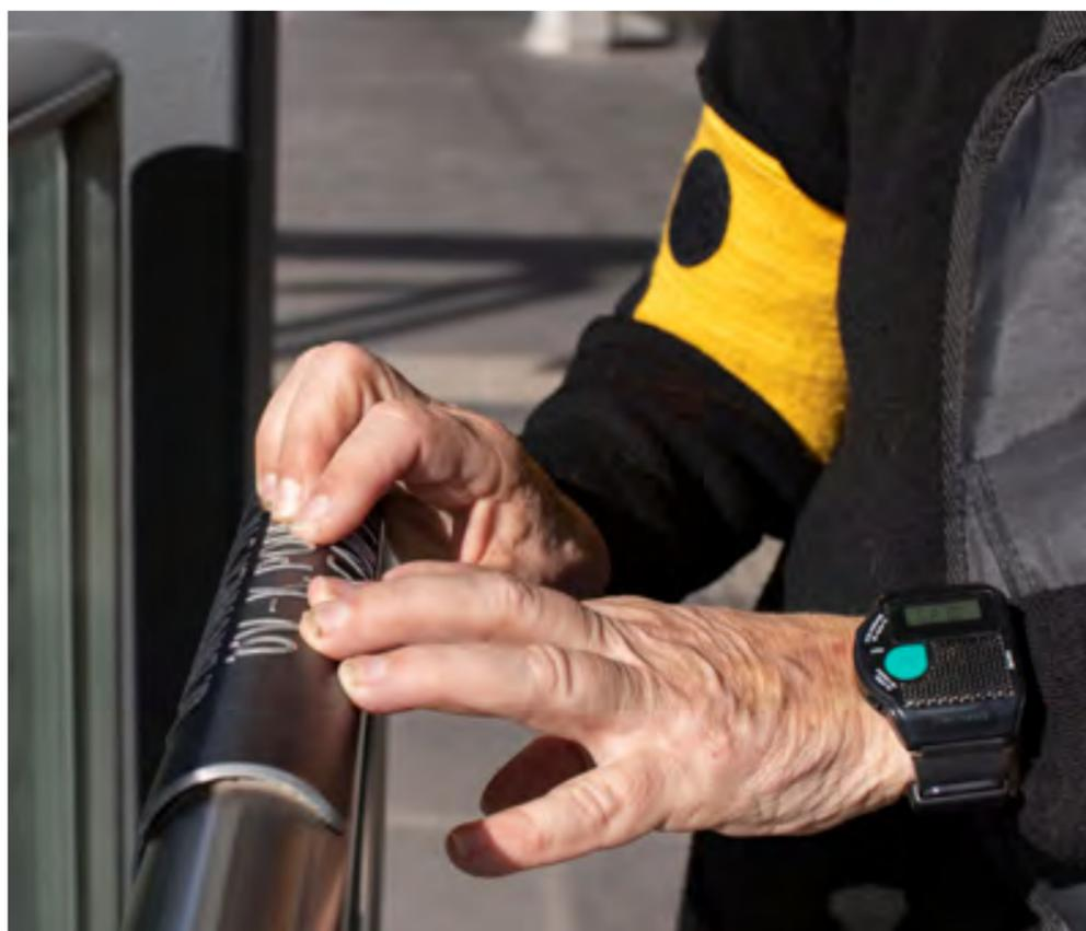
Barrierefreiheit wird ertastet: Taktile Handlaufbeschriftung am Bahnhof Praterstern.
